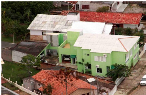
Figura 2: Frente e Lateral Norte da Sede da APA da Baleia Franca
