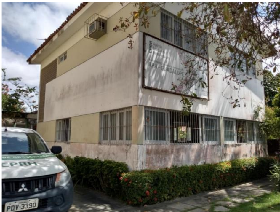
Existem sérios comprometimentos da pintura, grades e janelas.
