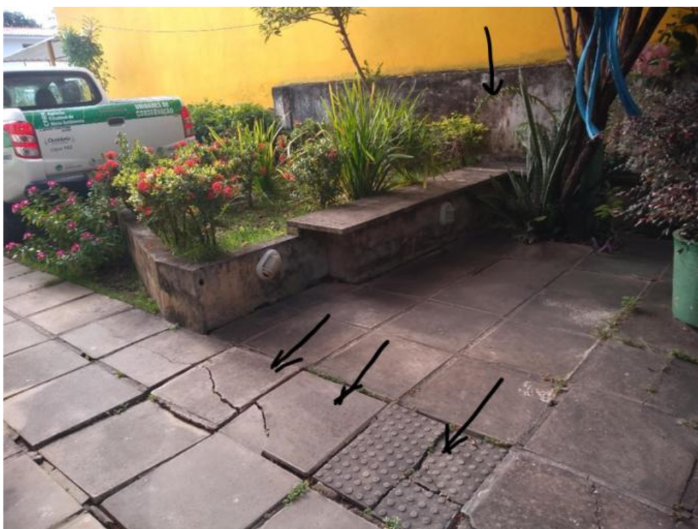
Afundamento de solo (não da estrutura) com comprometimento do pavimento que também apresenta danos e inadequação de acessibilidade.
