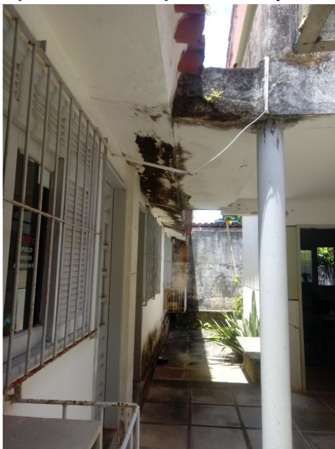
Impermeabilização do telhado, substituição das janelas de madeira, reboco e pintura.
