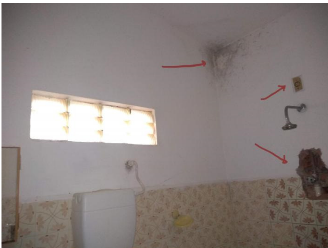
Vários remendos, arranjos técnicos, infiltrações, dentre outros
