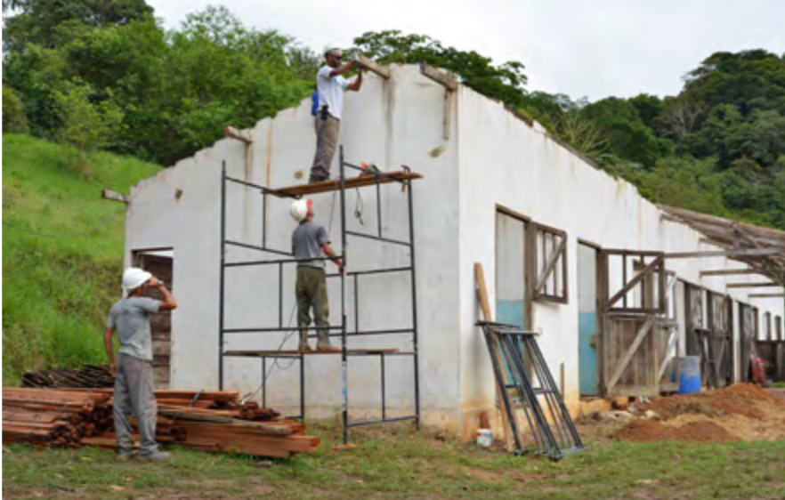
Reforma na antiga baia de cavalos que vai abrigar centro cultural.
