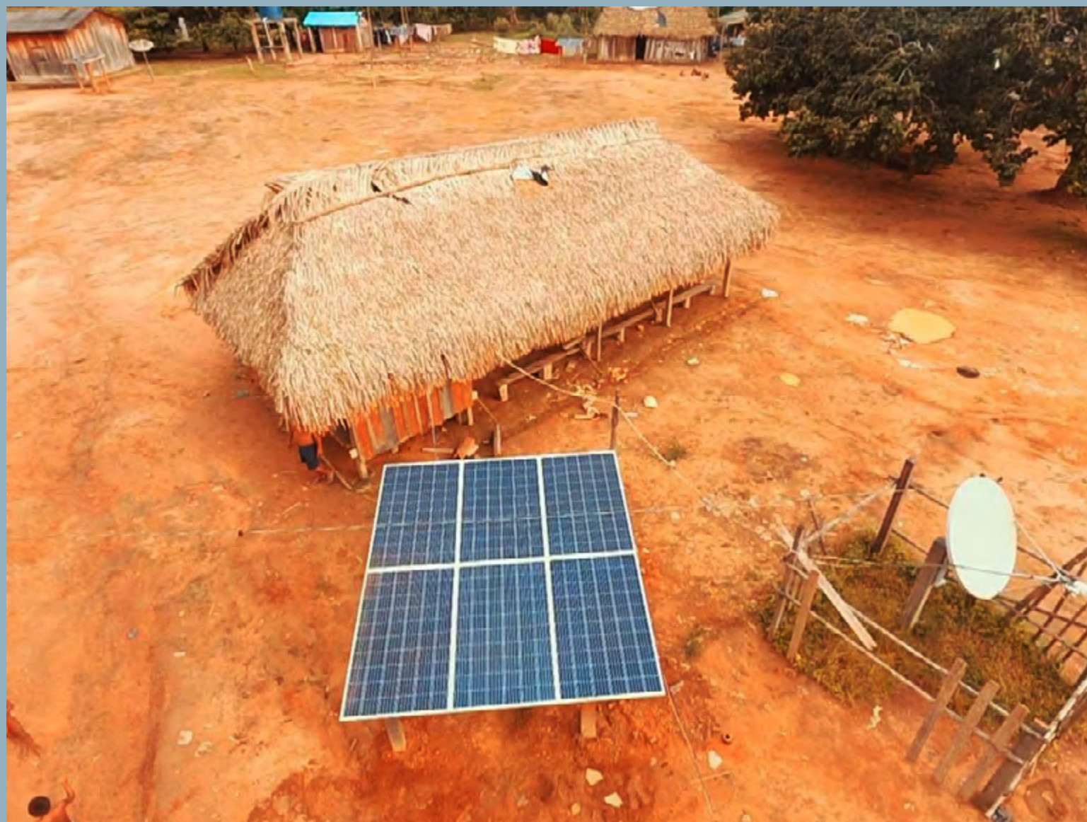
Instalação de Energia Solar em aldeia do povo Kayapó Foto: Instituto Kabu
