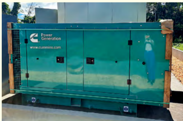
FIGURA 12: Gerador vinculado ao Data Center Modular (Fonte: SECEX)
